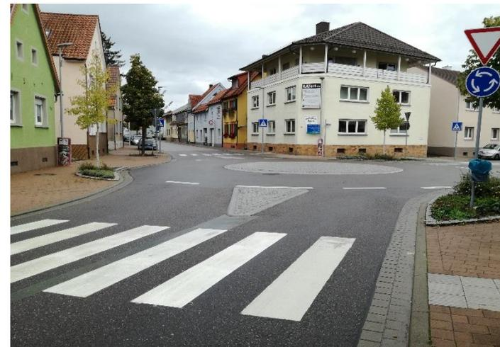
Ein geringerer Abstand ermöglicht eine direktere Wegeführung für den Fußverkehr nahe der Kreisfahrbahn und verbessert die Sichtbeziehungen zwischen zu Fuß Gehenden und ausfahrendem Kfz.
